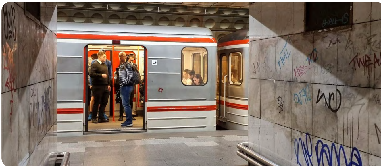
Obrázek 58 Aktuální stav nástupiště stanice metra Hradčanská, Zdroj: O. M. Hrubeš, 2026
