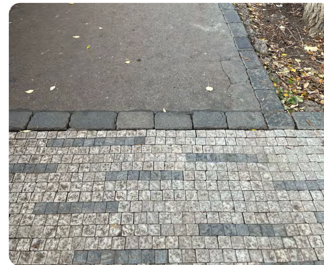
Obrázek 106 Asfalt a mozaiková dlažba, zdroj: ONplan, 2025
